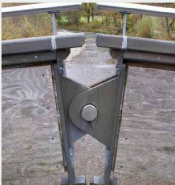
◀ Das Herzstück der Brücke ist der Stahlbolzen, der die beiden Bogenteile verbindet.
